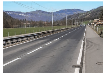
Strassensanierung Kantonsstrasse Richtung Dallenwil
