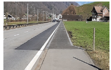
Strassensanierung an der Kantonsgrenze
