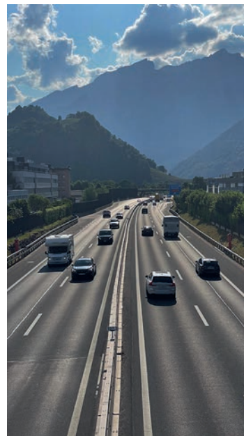
Nicht immer fliesst der Verkehr auf der A2 so wie hier.
