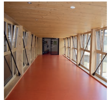
Die neue Passerelle mit verbindenden Elementen
