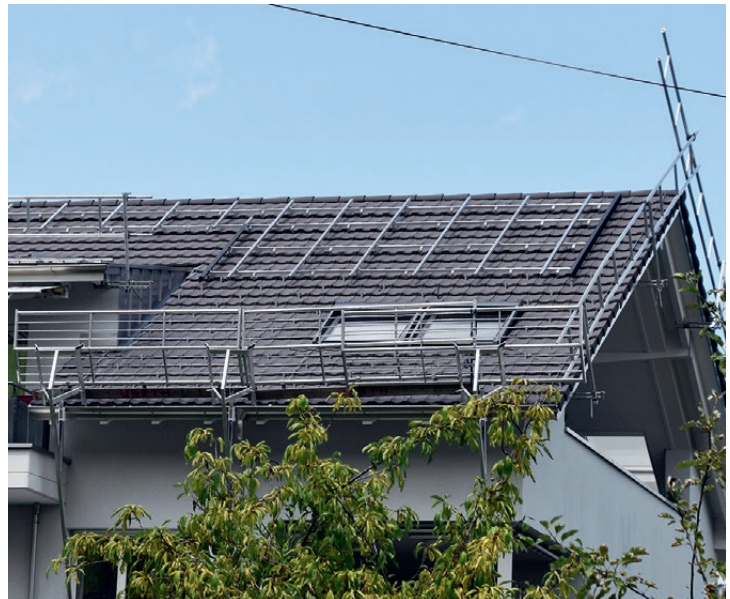
Vorbereitungsarbeiten für die spätere Montage der Solarpanels
