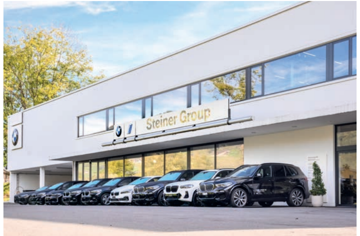
Steiner Group AG, direkt an der Engelberger Aa zwischen Oberdorf und Buochs
